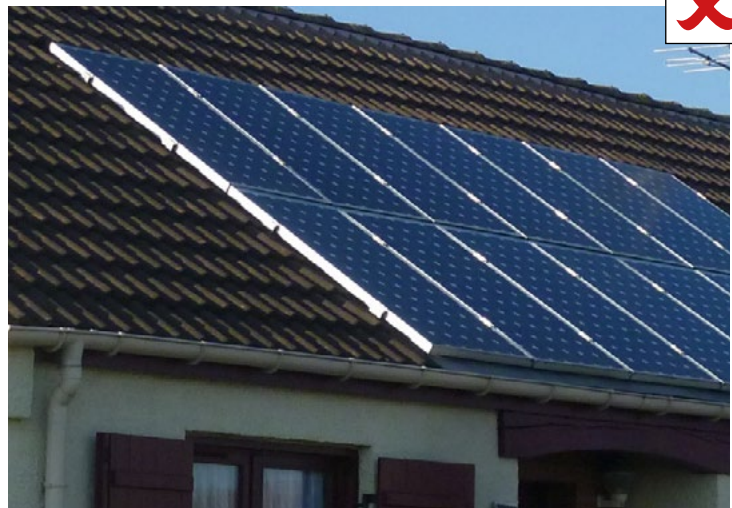
Panneaux non encastrés, bleus, polycristallins, cadre visible
