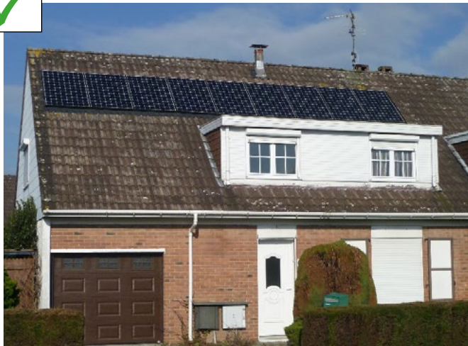
Panneaux discrets sur toute la largeur de la toiture
